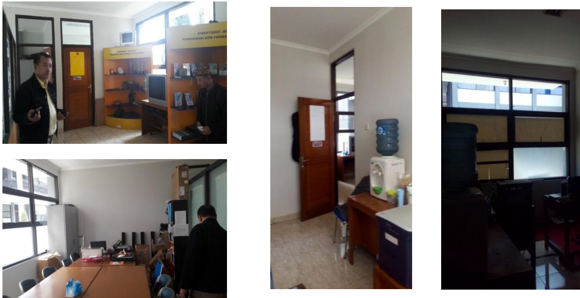
Gambar.2. Kondisi Visual & Fungsi Ruangan Awal. Ruang. Rapat dan Ruang. Kerja
